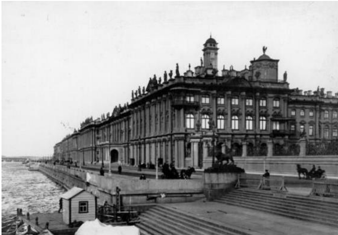
Рис.69. Вентиляционно-отопительная труба на крыше Зимнего дворца
